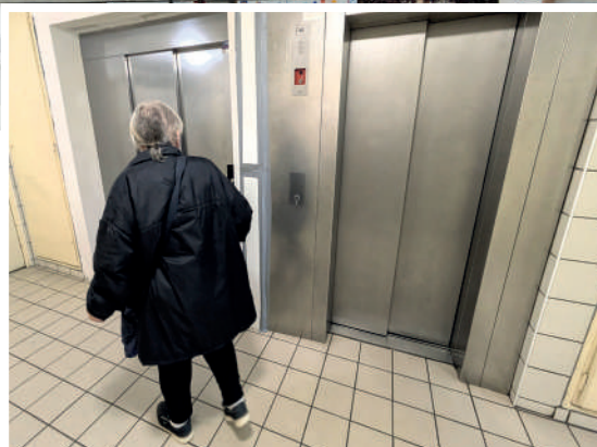
Ascenseur rénové et remis en service au 8 rue Firmin Gémier
