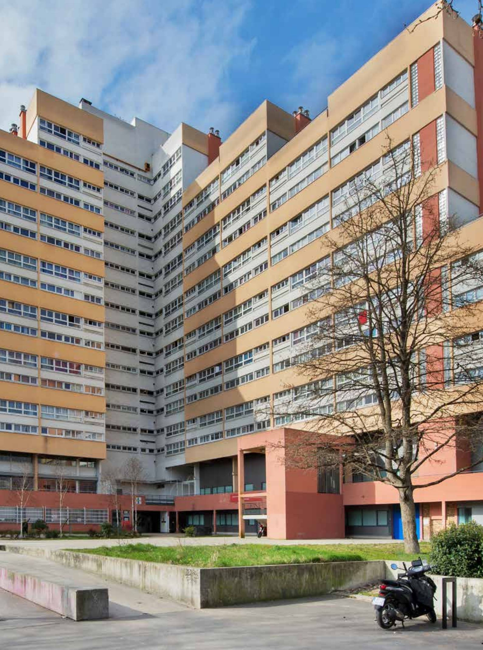
Résidence Avenue de la République, Siège de l'OPH d'Aubervilliers.
