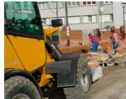
▲ Mise en chantier des espaces extérieurs du 38 Hémet-42 Casanova
