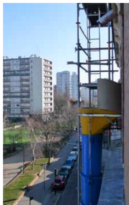
▲ Des travaux importants
