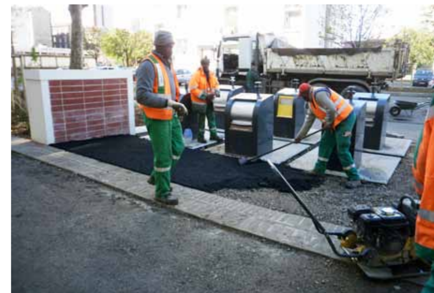
▲ Installation de colonnes enterrées
