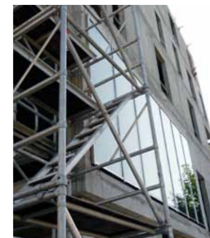
▲ Résidence Rosa Luxemburg en construction
