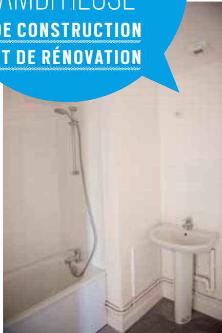
▲ Rénovation sanitaire plomberie
