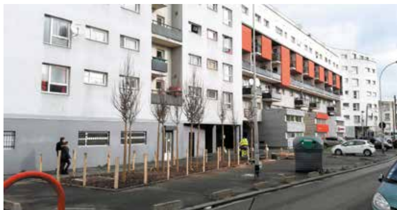
89-99 rue Heurtault, où l'ensemble des halls d'entrée ont été entièrement rénovés.
