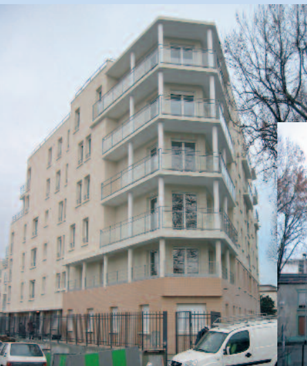
Passage Moglia : 42 logements locatifs nouveaux
