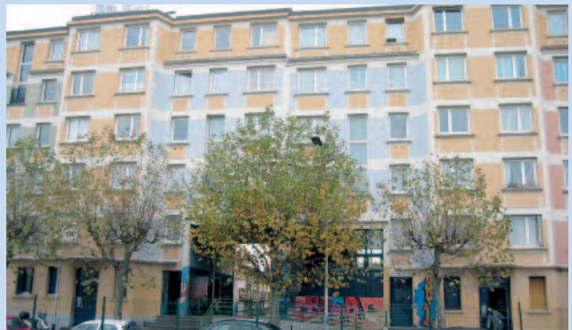
Albinet : démolition des cages d'escaliers 6 et 8
